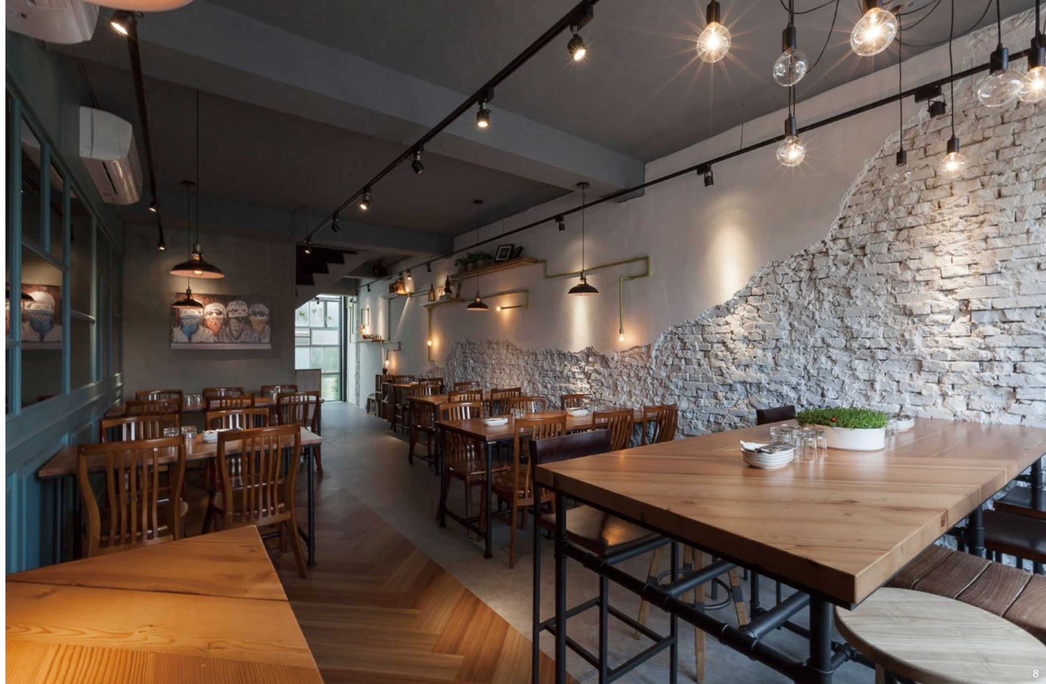
8. 牆面以大面積鏟出剖面，展露出磚牆的粗糙紋理，並延伸連貫於複層之間。9.10. 牆面上的管線裝飾兼具壁燈功能，巧妙地將線盒隱藏其中，同時兼顧了往後維修的方便性。
